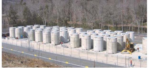
*Barricas de almacenamiento cargadas de combustible gastado en plataforma de almacenaje en la Central Haddam Neck en Meriden, CT. (Cortesía de: Connecticut Yankee)*
