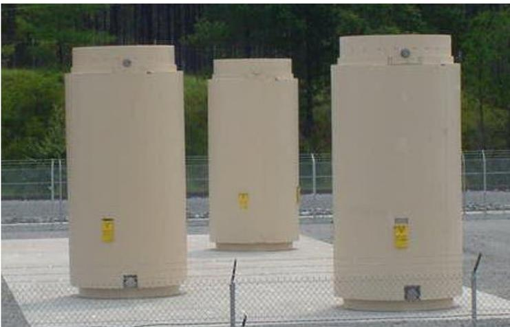
*Barricas transportables para el almacenamiento de combustible gastado en una plataforma de almacenaje.*
